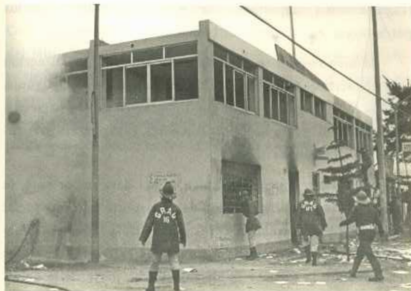
Bomberos apagan un incendio en la Municipalidad de San Juan de Miraflores producto de las manifestaciones en el día del Paro. Caretas, julio de 1977.
